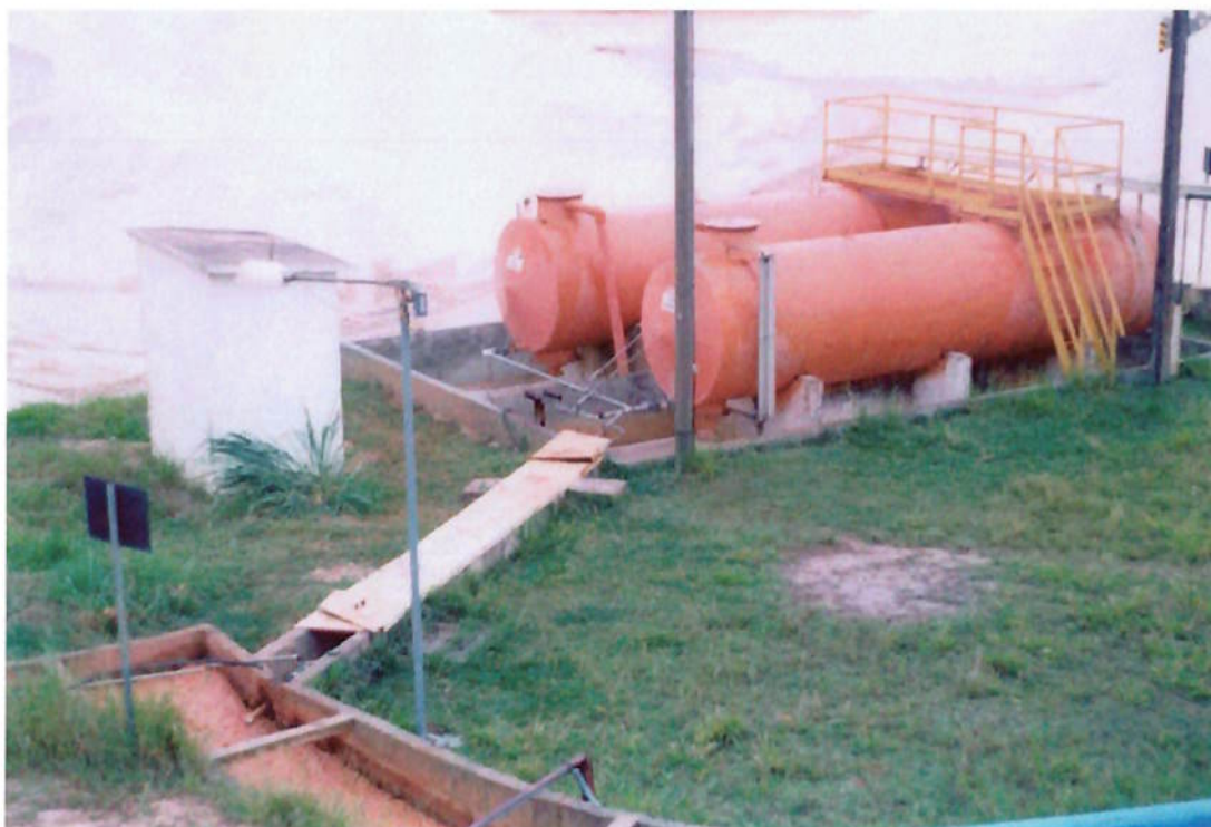
Figura 6.14 – reservatório e dosador de ácido sulfúrico – Mineração Jundu.
