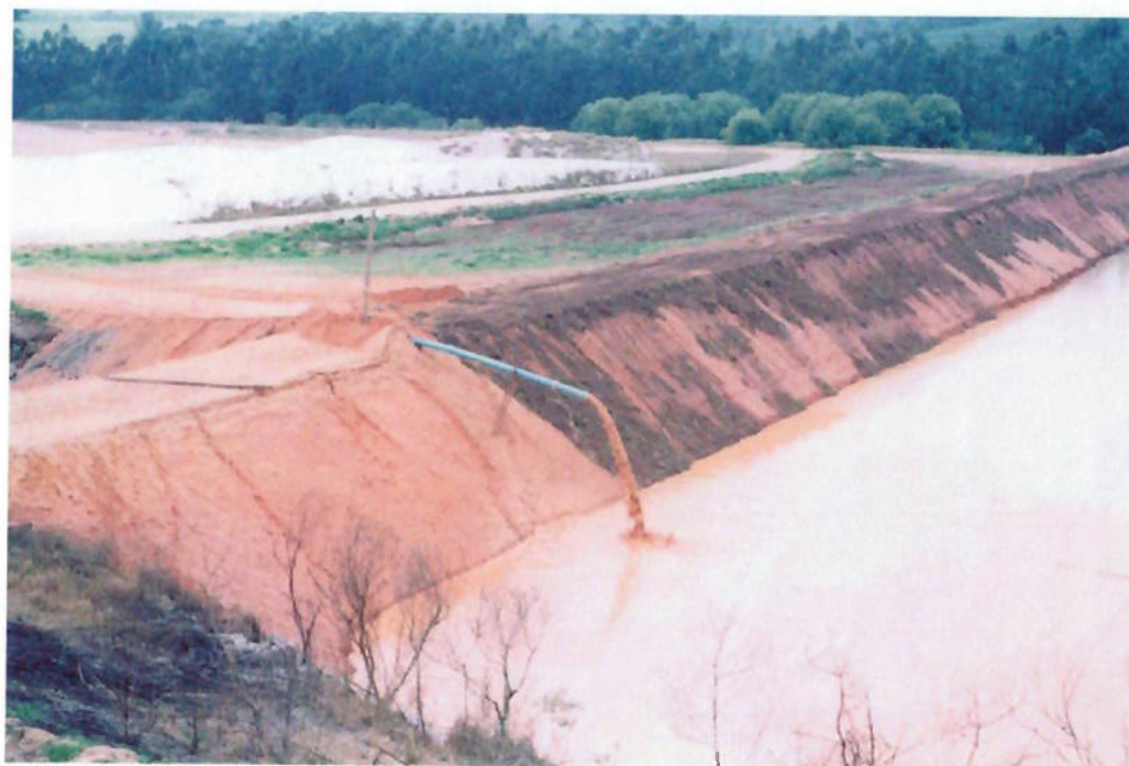
Figura 6.13 – caixas de decantação – Mineração Jundu.
