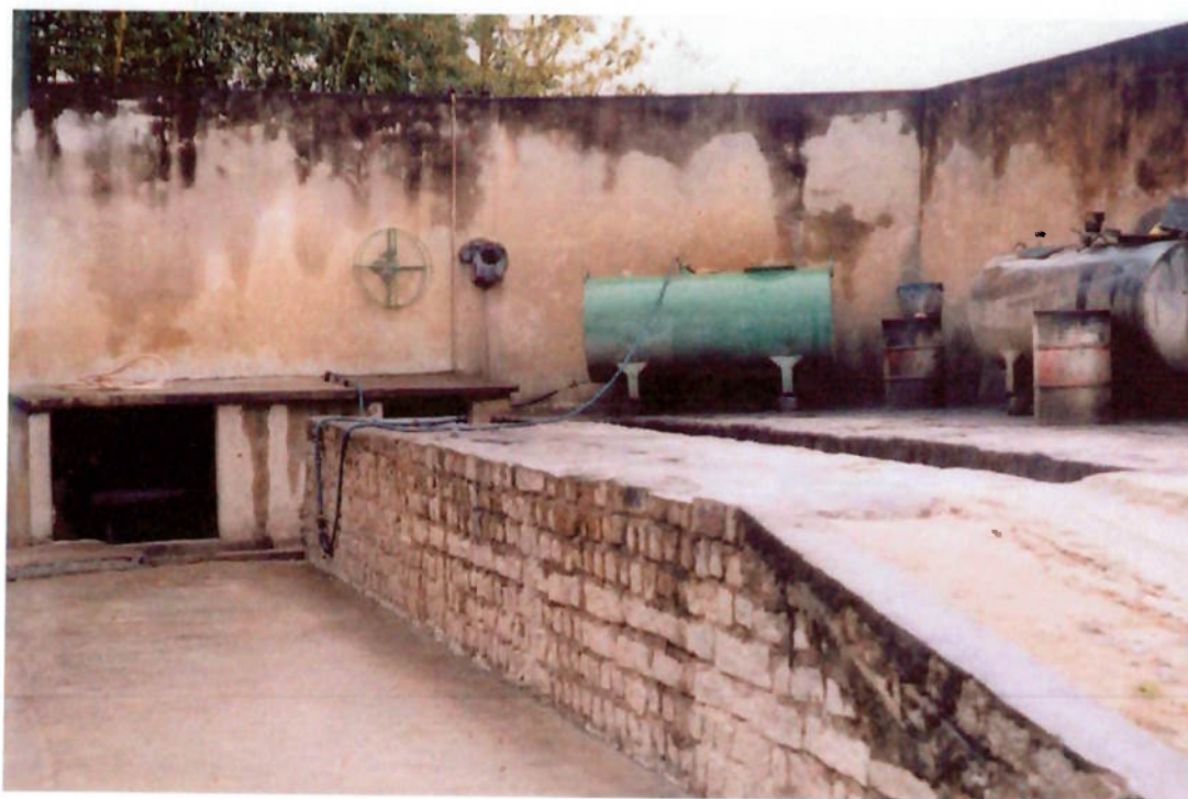
Figura 6.20 – caixa de decantação de óleos e graxas – Mineração Viterbo Machado Luz.
