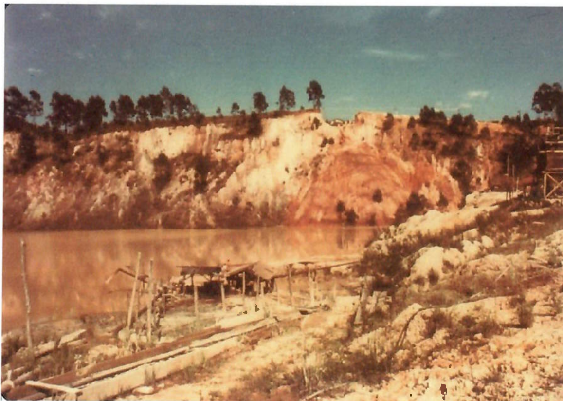
Figura 7.1 – vista dos taludes em processo de erosão – área abandonada da Mineração Giosa – Embu SP
