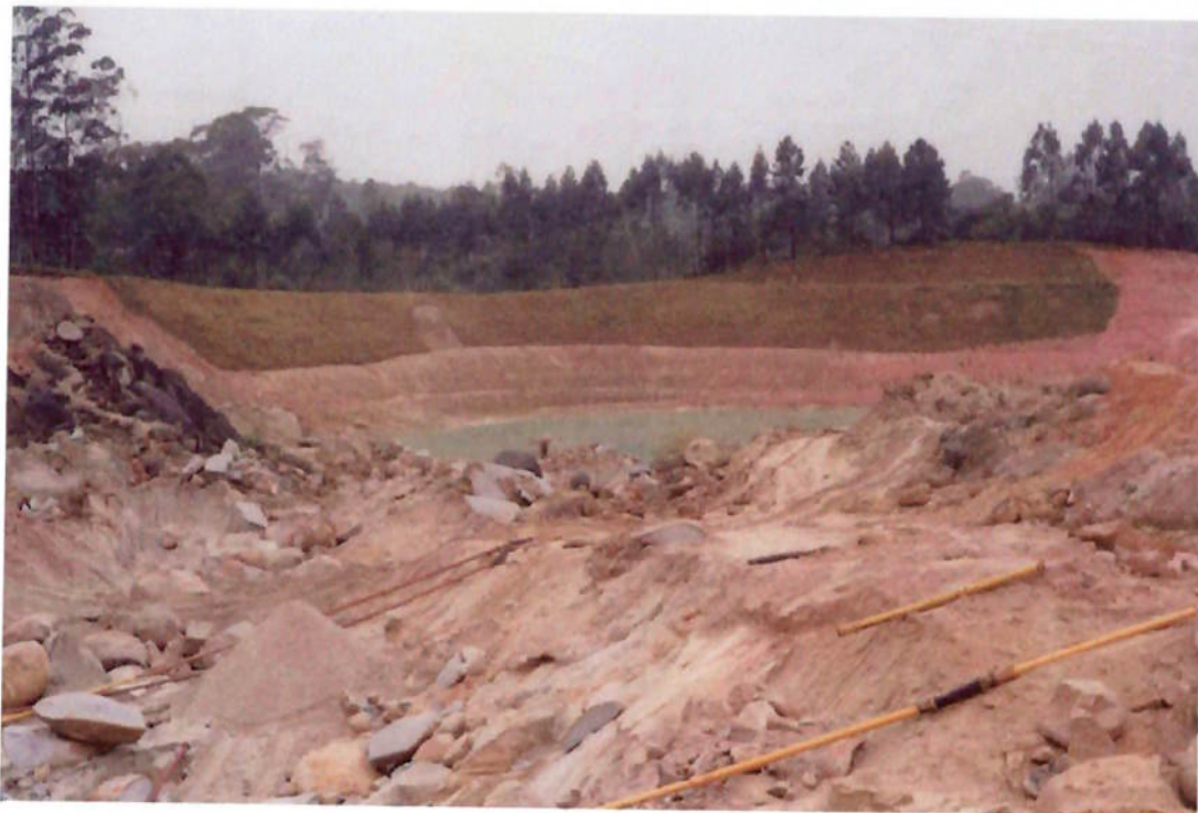
Figura 6.15 – processo de “retaludamento” concomitante com o desenvolvimento da lavra – Mineração Viterbo Machado Luz.
